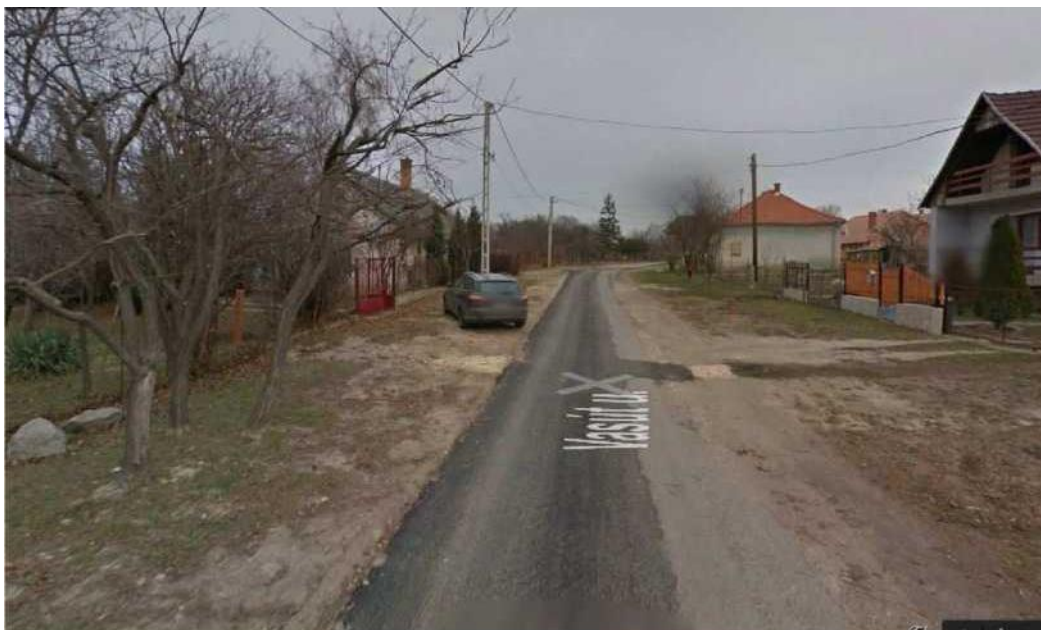
53. ábra Vasút utca részlet (Forrás:Google Maps)
